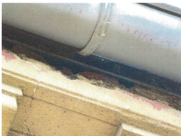
č. 22 – 23 Detaily spojení střešní konstrukce se zdivem atik, budova A
