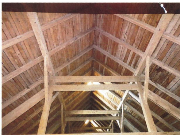
č. 58 Detail konstrukce krovu, budova B
