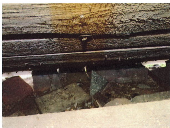
č. 50 Detaily poškození atikového zdiva, budova A, východní část
