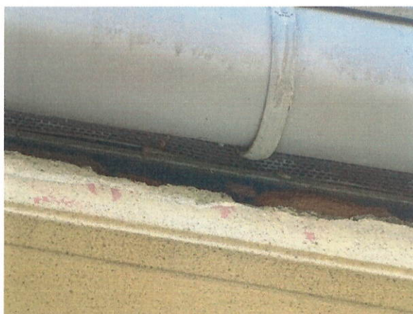
č. 22 – 23 Detaily spojení střešní konstrukce se zdivem atik, budova A
