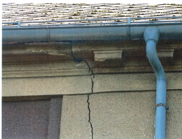
č. 66 Detail poškození zdiva, budova A
